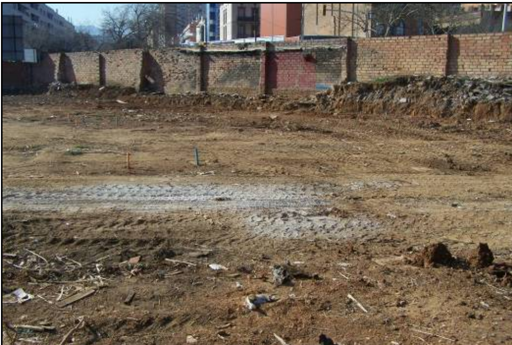
Fotografia 2: Fase 2 (pk. 0+050/0+100) del col·lector abans de l'inici de les obres.
