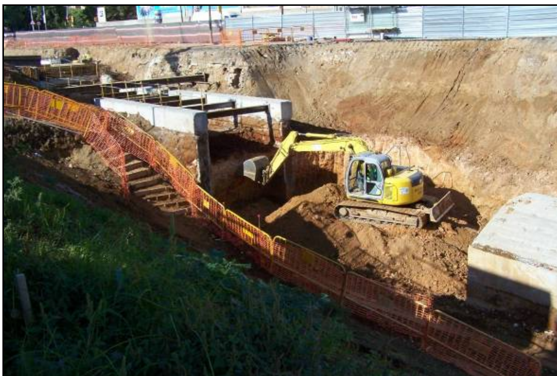
Fotografia 20: Excavació entre pantalles amb la giratòria. Fases 1 i 2, pk. 0+000/0+100.
