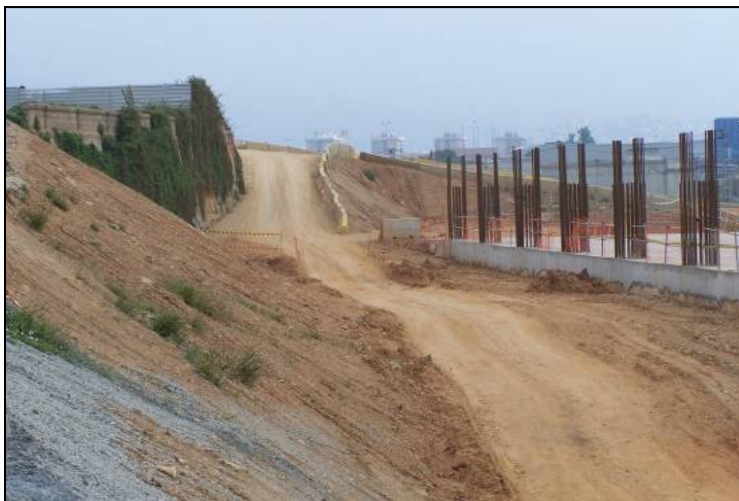
Fotografia 6: Fase 8 (pk. 0+620/0+700), abans de l'inici de l'excavació.
