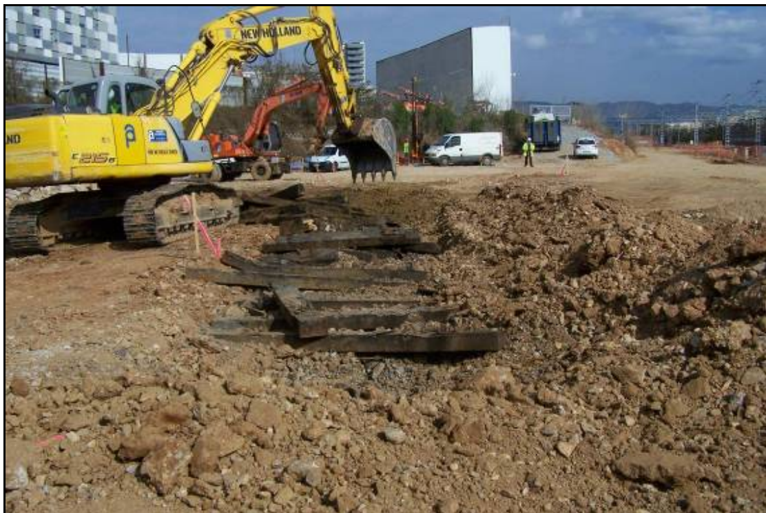
Fotografia 31: Extracció de vies de l'antiga estació de mercaderies, Fase 5 (pk. 0+500).
