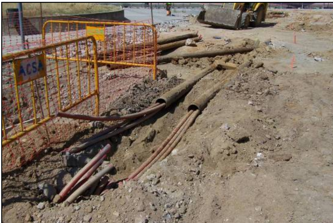
Fotografia 37: Cablejat elèctric en Fase 1 (p. 0+000/0+050).
