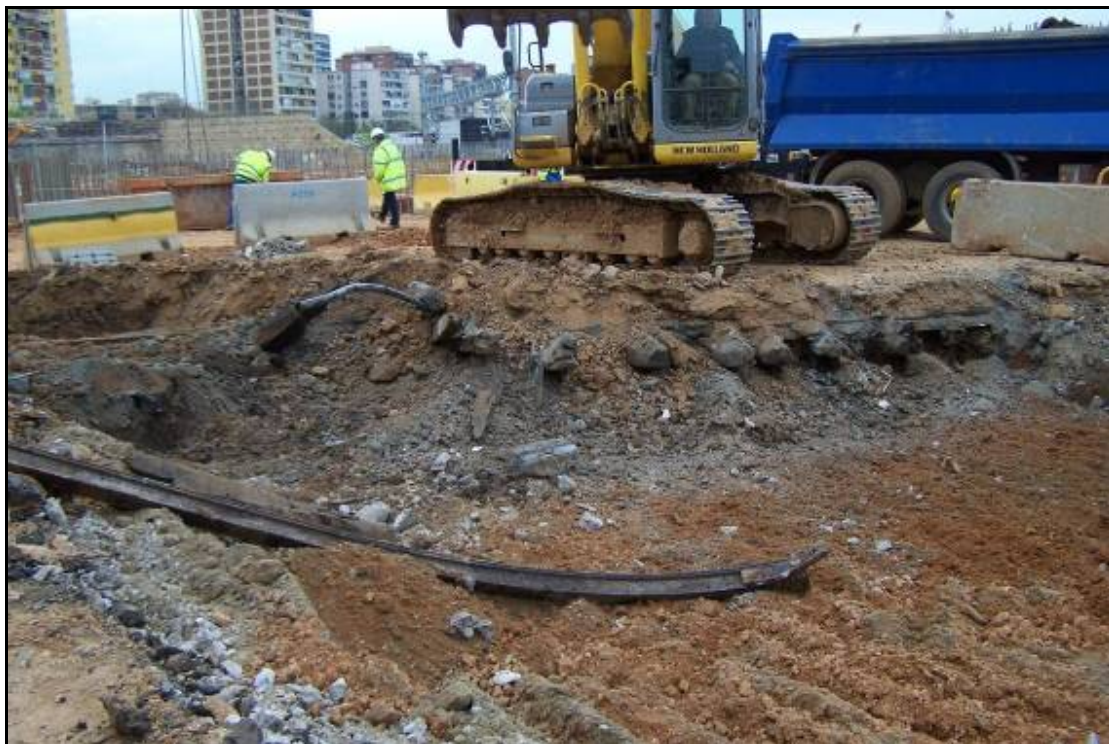
Fotografia 29: Vies i travesses de fusta de l'antiga estació de mercaderies de RENFE de la Sagrera, entre final de Fase 2 i inici de Fase 3A (pk. 0+150).
