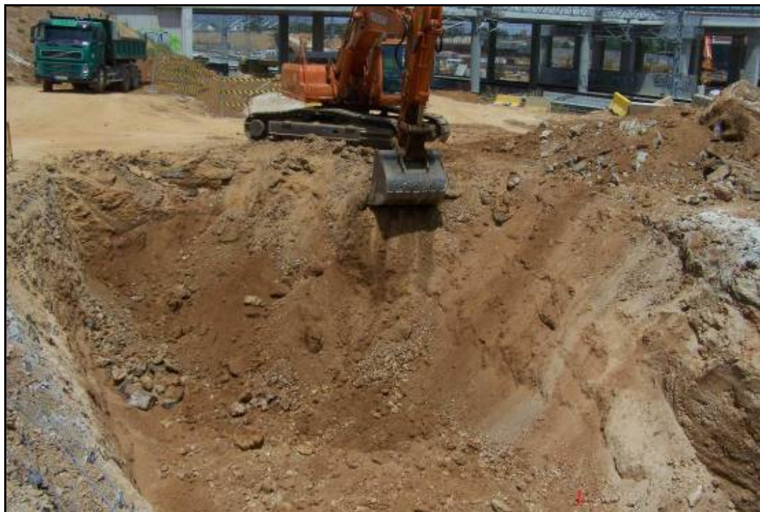
Fotografia 13: Excavació amb giratòria en la Fase 4B, pk. 0+240/0+290.
