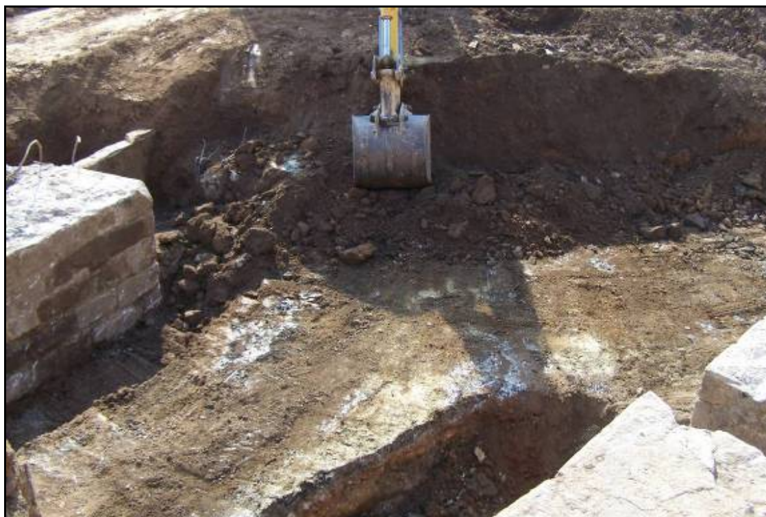
Fotografia 50: Neteja del paviment d'asfalt UE 103.
