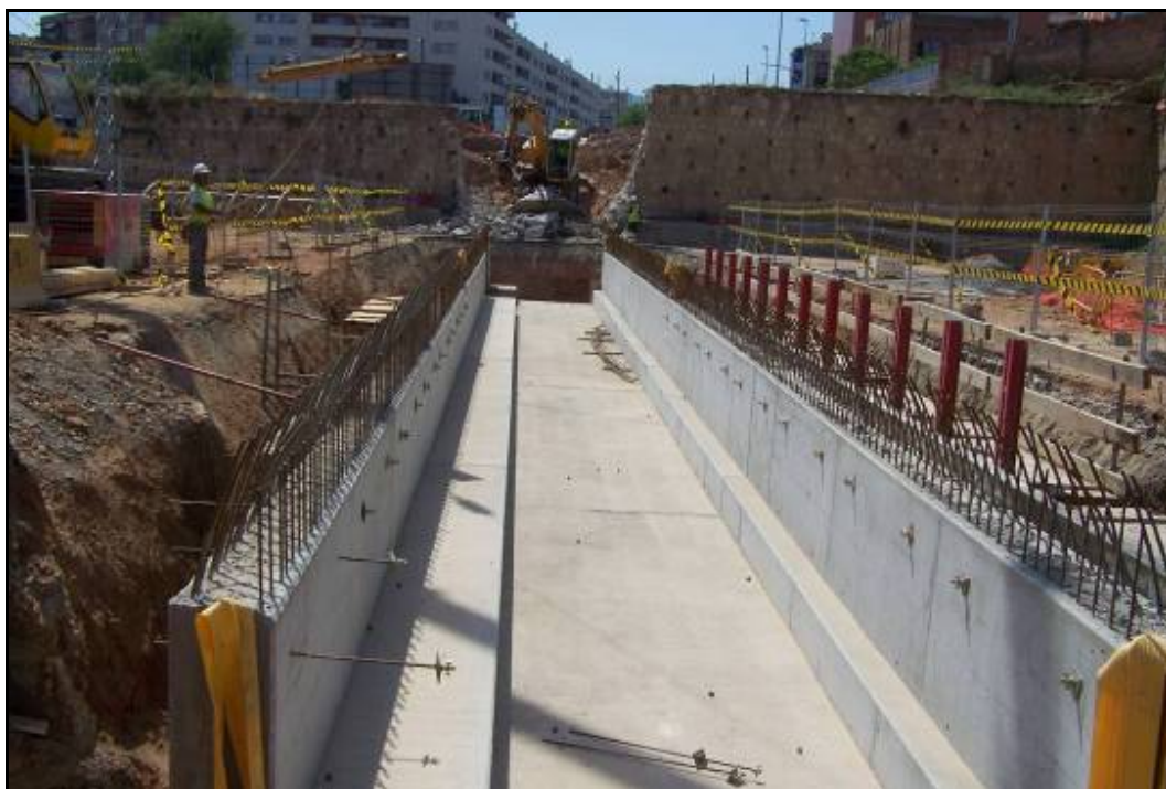
Fotografia 17: Trencament del mur de contenció de terres entre el nivell superior de la Fase 2 (pk. 0+050/0+100) i l'inferior de la Fase 3A (pk. 0+100/0+150).
