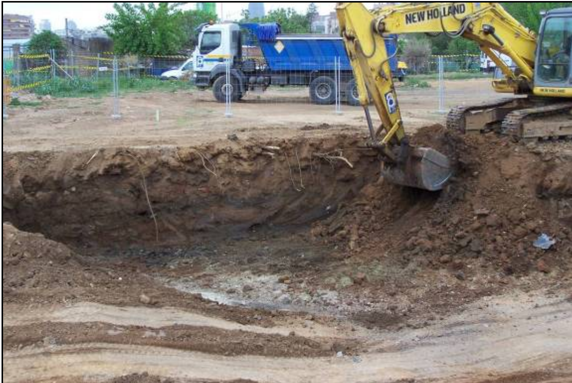
Fotografia 39: Excavació de l'estrat superficial UE 100, en Fase 2 (pk. 0+050/0+100).
