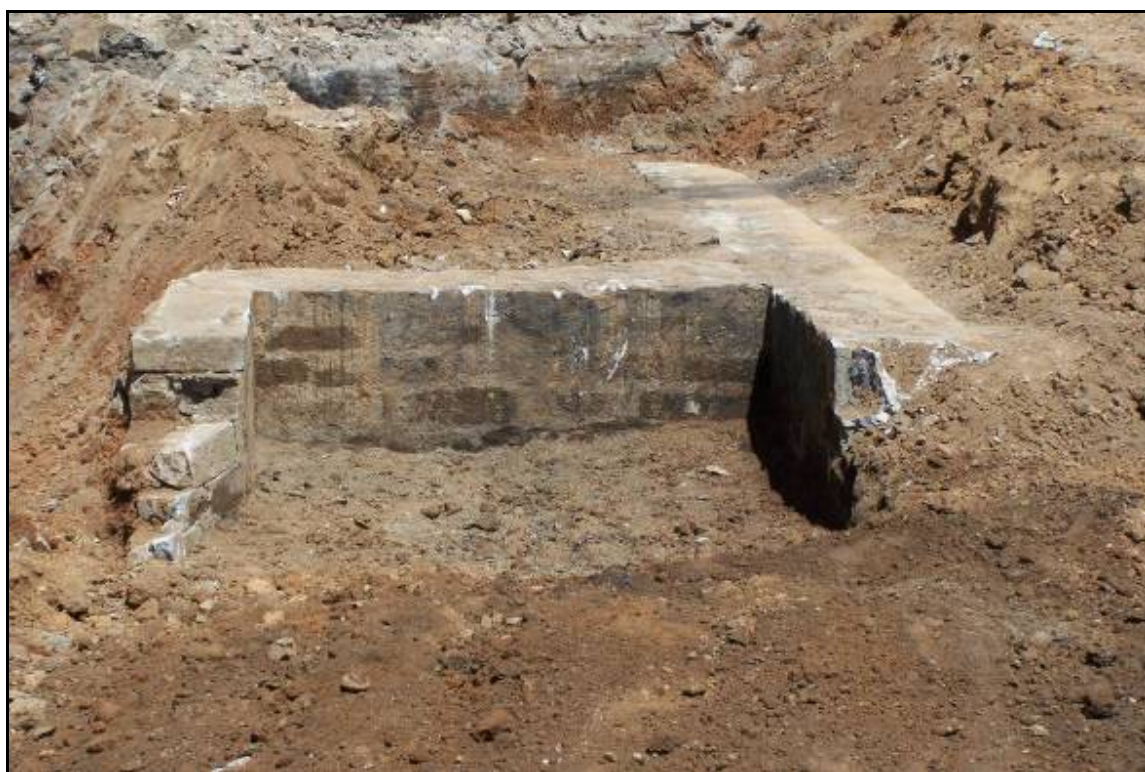
Fotografia 54: Ampliació d'estructures UE 108 i 113.
