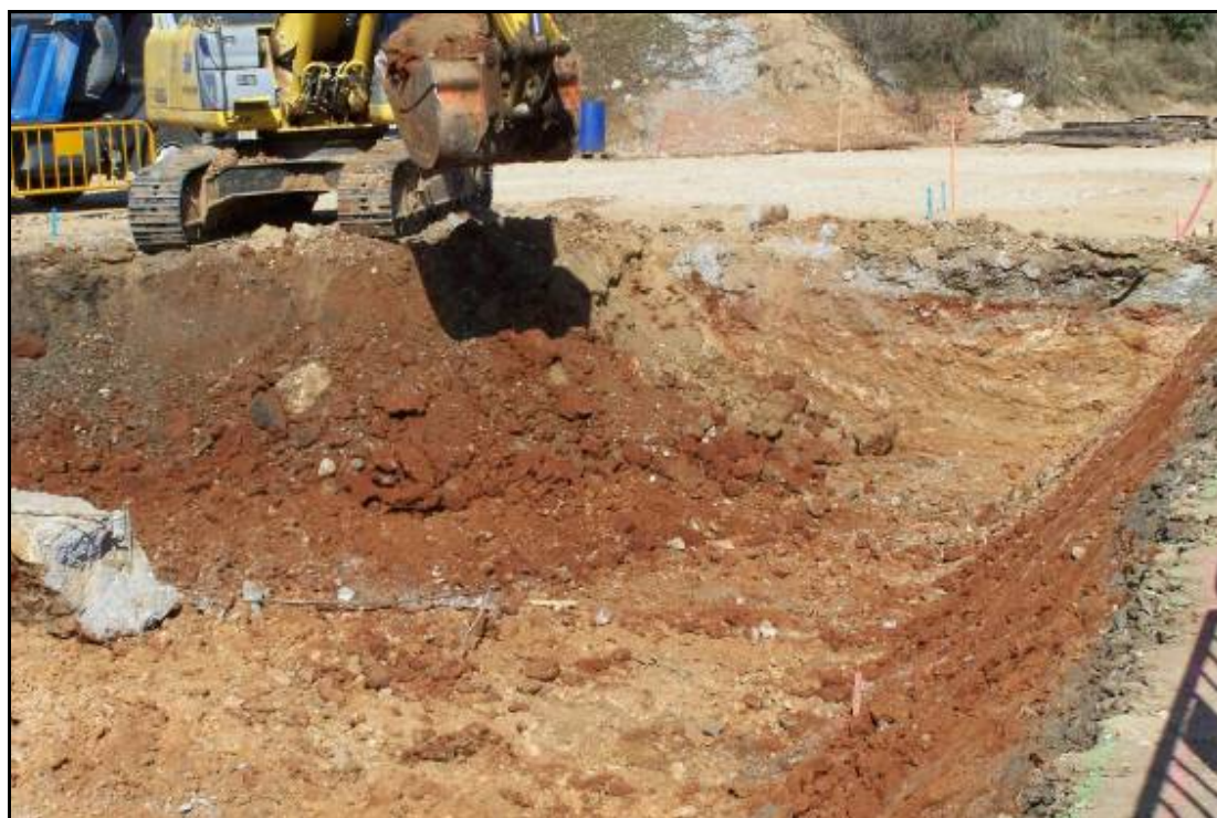
Fotografia 28: Excavació d'un nivell de graves en la Fase 5, pk. 0+340/0+440.
