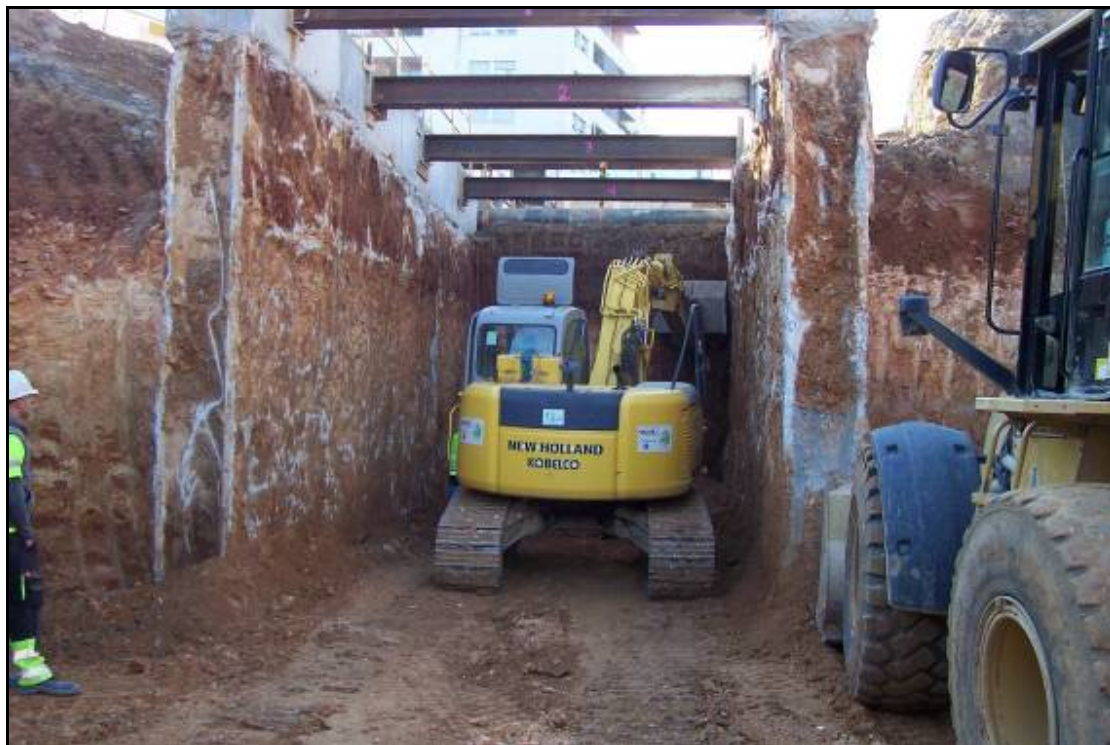
Fotografia 21: Avançament de l'excavació entre pantalles amb la giratòria. Fases 1 i 2, pk. 0+000/0+100.
