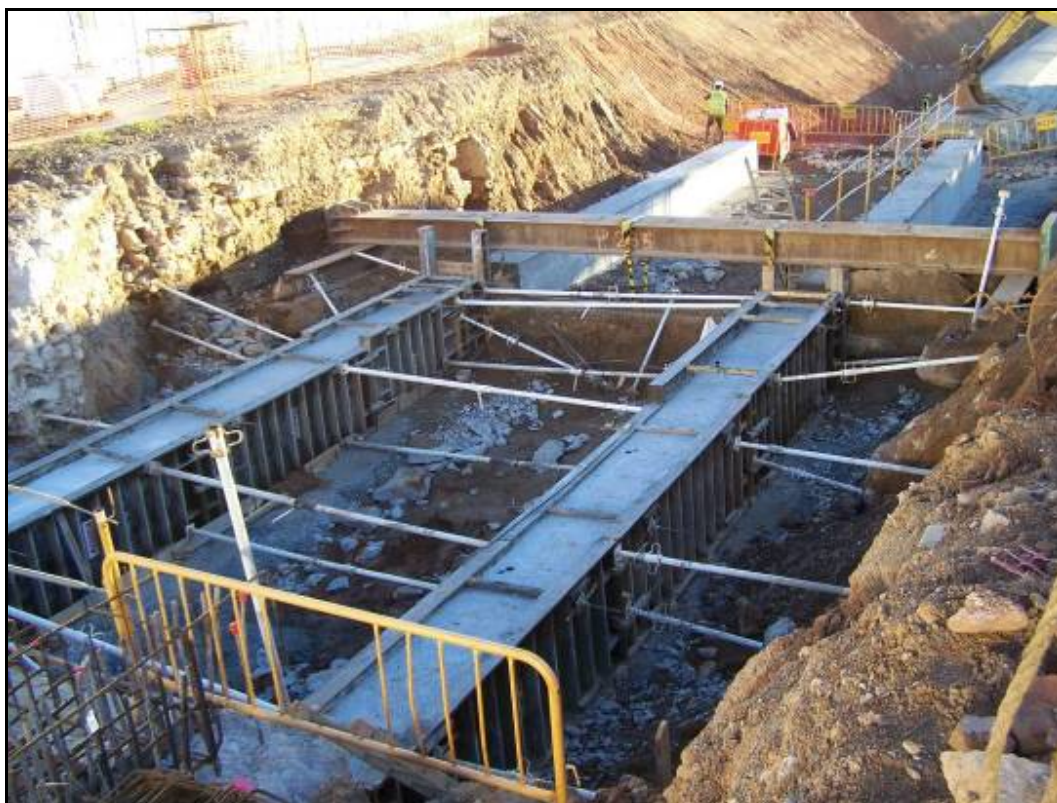
Fotografia 18: Encofrats de les pantalles en la Fase 1, pk. 0+000/0+050.
