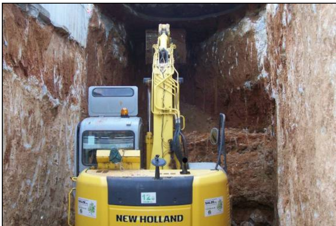
Fotografia 22: Arribada a l'entroncament amb col·lector existent al carrer de Garcilaso (pk. 0+000).
