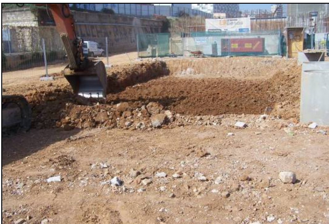
Fotografia 12: Excavació amb giratòria en la Fase 3C, pk. 0+170/0+220.
