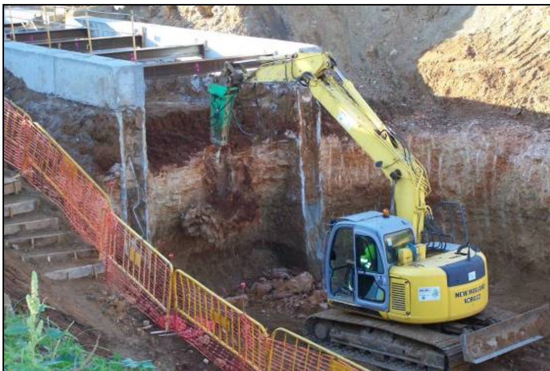
Fotografia 27: Trencament de crosta calcària amb martell neumàtic en Fase 1, pk. 0+050.
