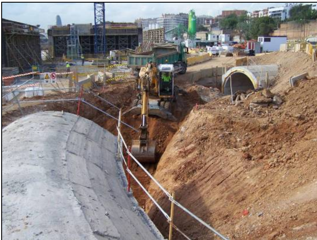
Fotografia 11: Excavació amb giratòria en la Fase 3B, pk. 0+150/0+170.
