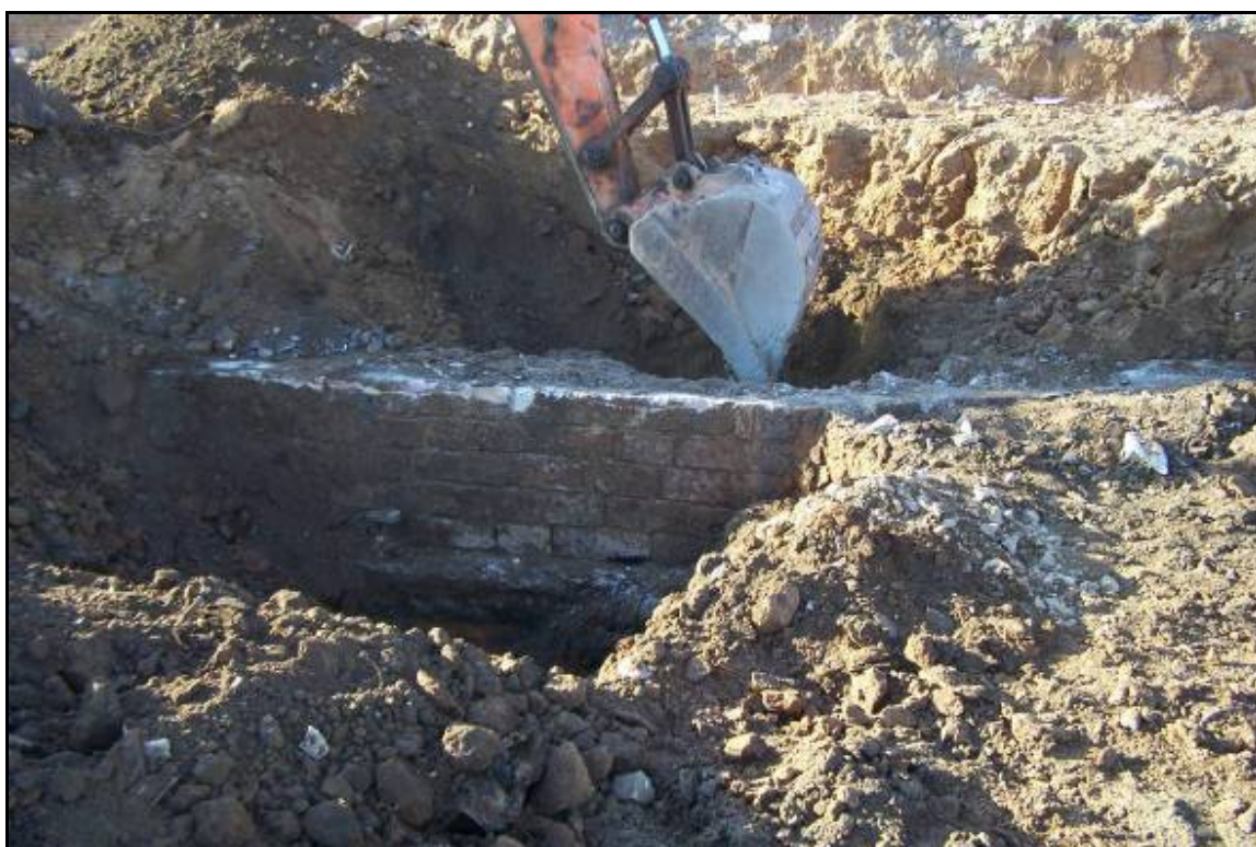
Fotografia 42: Mur UE 106 per la cara vista durant els treballs de neteja.
