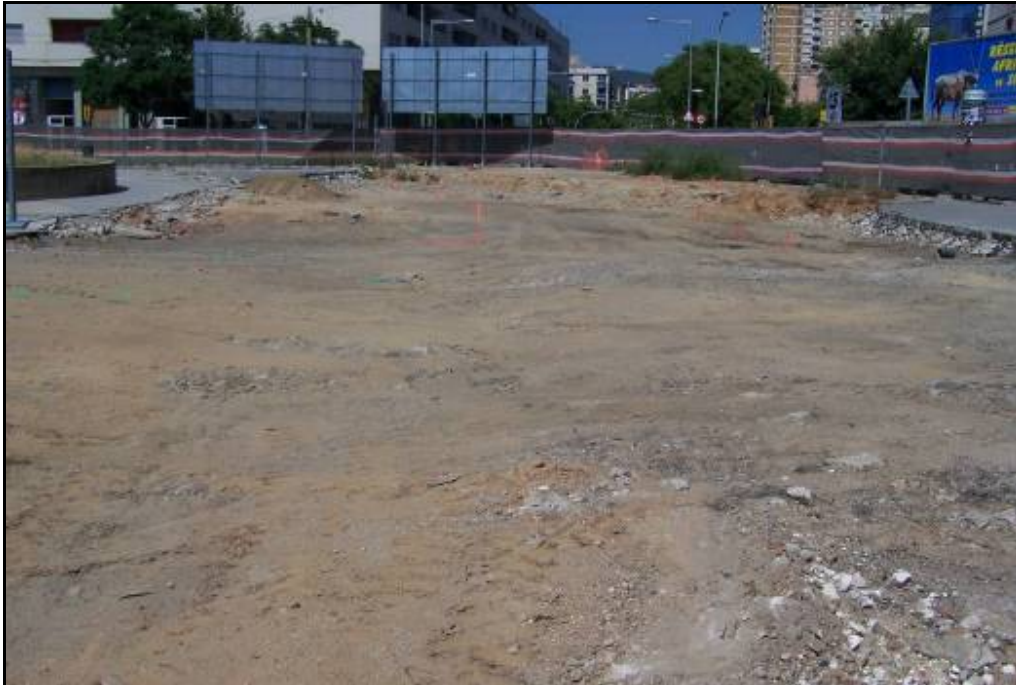
Fotografia 1: Fase 1 (pk. 0+000/0+050) del col·lector abans de l'inici de les obres.
