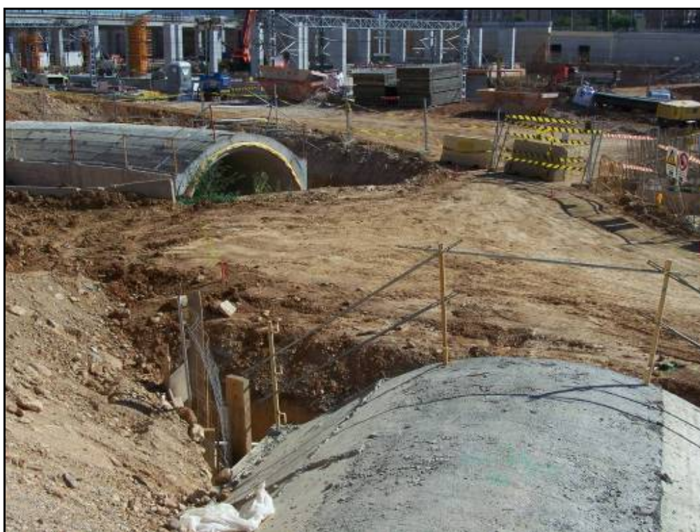
Fotografia 4: Fase 3B (pk. 0+150/0+170) ubicada en una zona de trànsit de vehicles, entre dos trams del col·lector.
