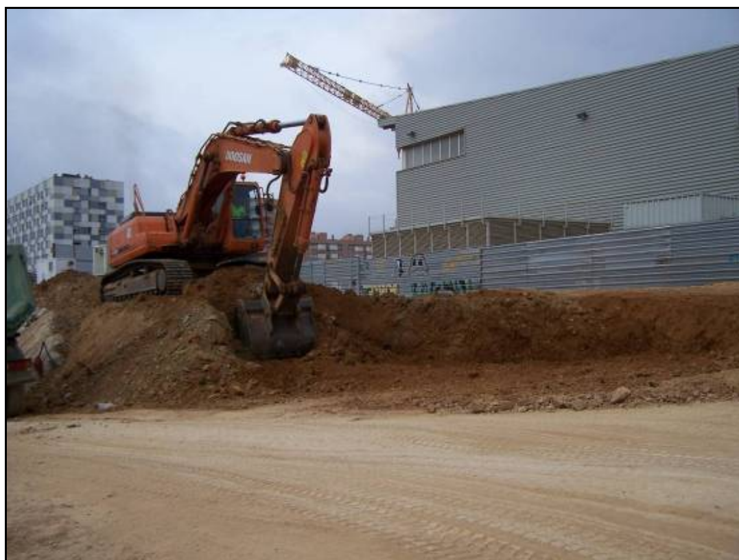
Fotografia 16: Excavació amb giratòria en la Fase 8, pk. 0+620/0+700.
