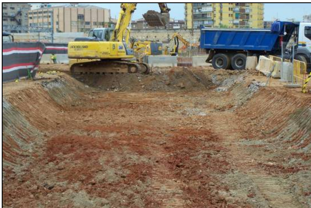
Fotografia 10: Excavació amb giratòria en la Fase 3A, pk. 0+100/0+150.
