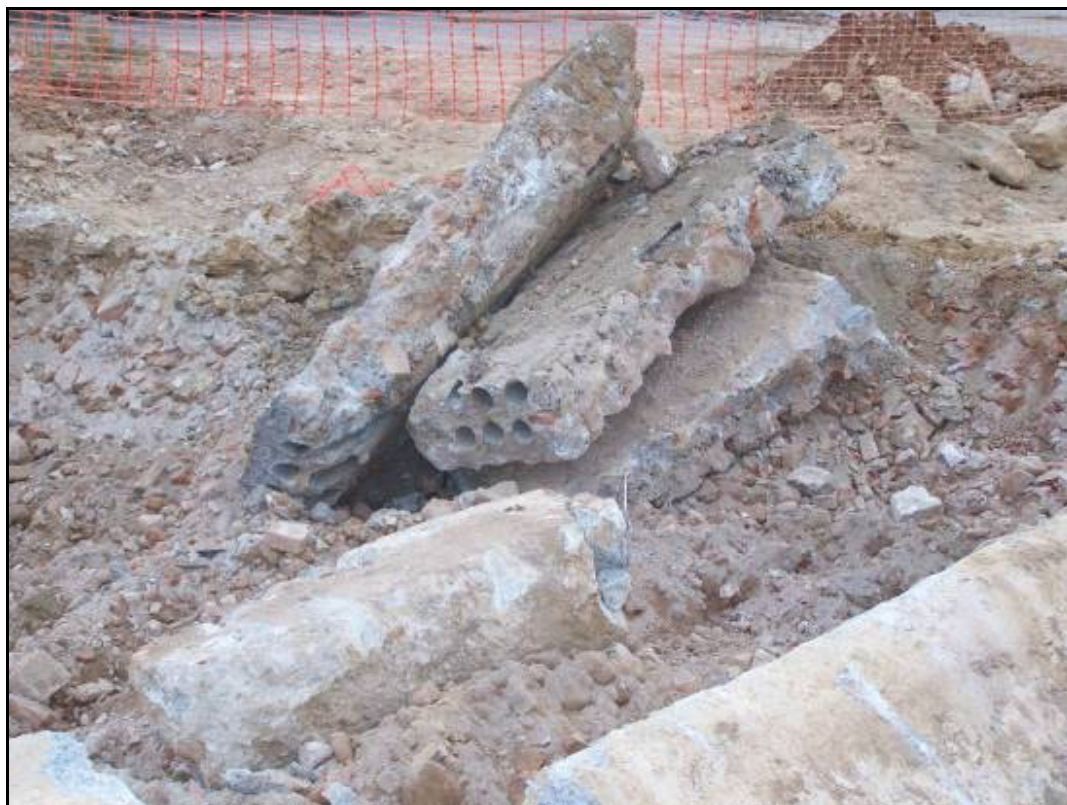
Fotografia 38: Protecció de serveis arrancats en Fase 1 (pk. 0+050).
