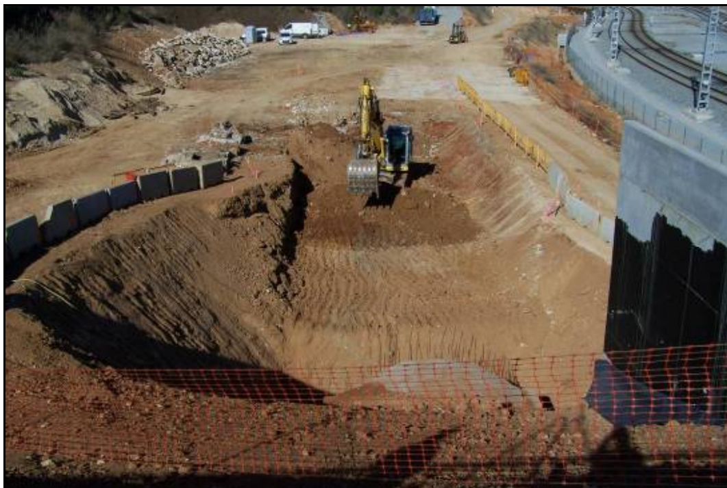
Fotografia 7: Tram de les obres del col·lector (Fase 5, pk. 0+350) a l'antiga plataforma de l'estació de mercaderies de RENFE.
