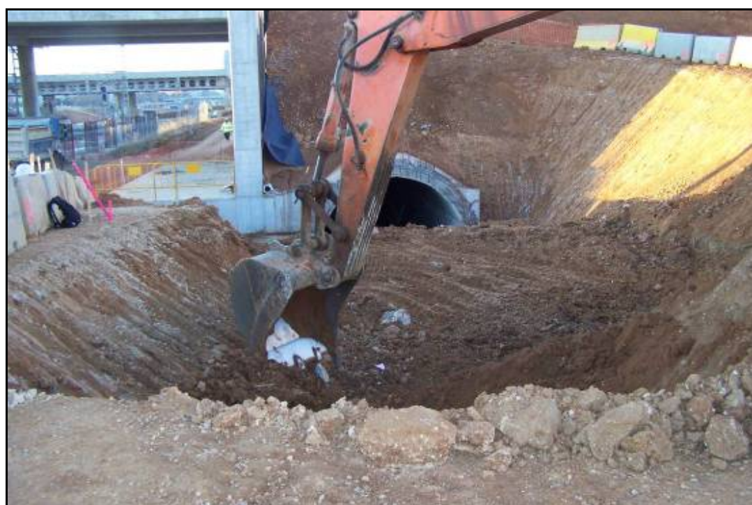
Fotografia 14: Excavació amb giratòria en la Fase 5, pk. 0+440/0+510.
