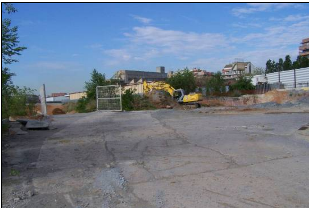
Fotografia 8: Zona de la plataforma per a la futura estació d'autobusos, Fase 6 (pk. 0+450/0+510).
