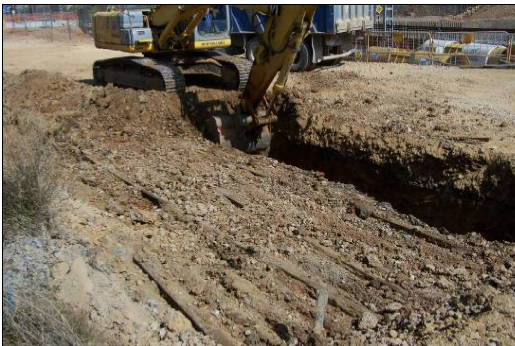
Fotografia 35: Aparició in situ d'un canvi de vies en Fase 7 (pk. 0+580).
