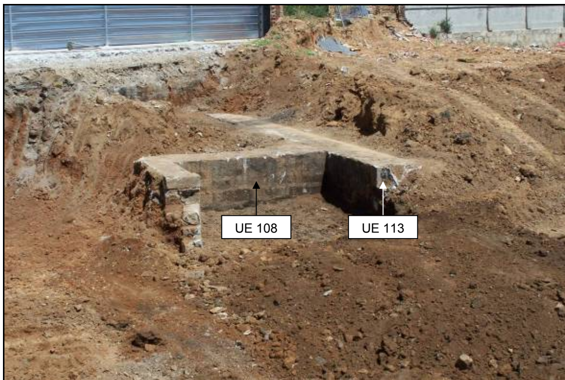
Fotografia 53: Ampliació d'estructures UE 108 i 113.
