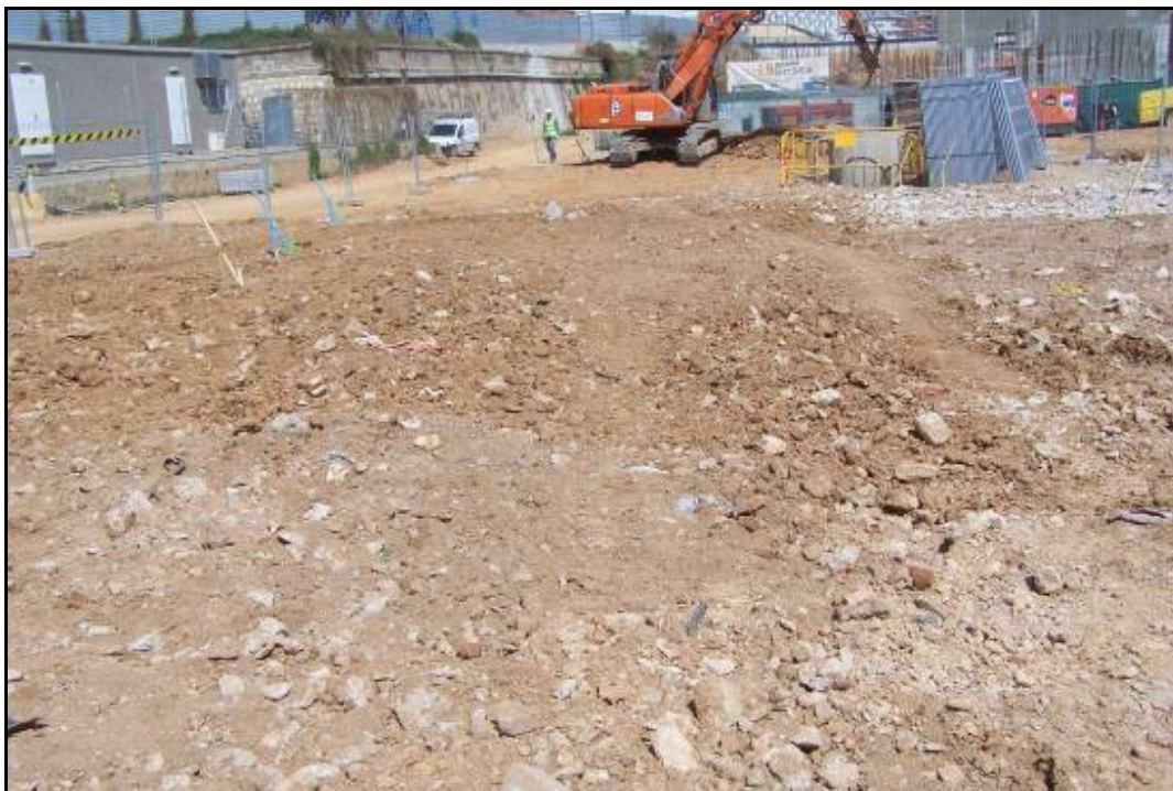
Fotografia 5: Fase 3C (pk. 0+170/0+220), abans de l'inici de l'excavació.
