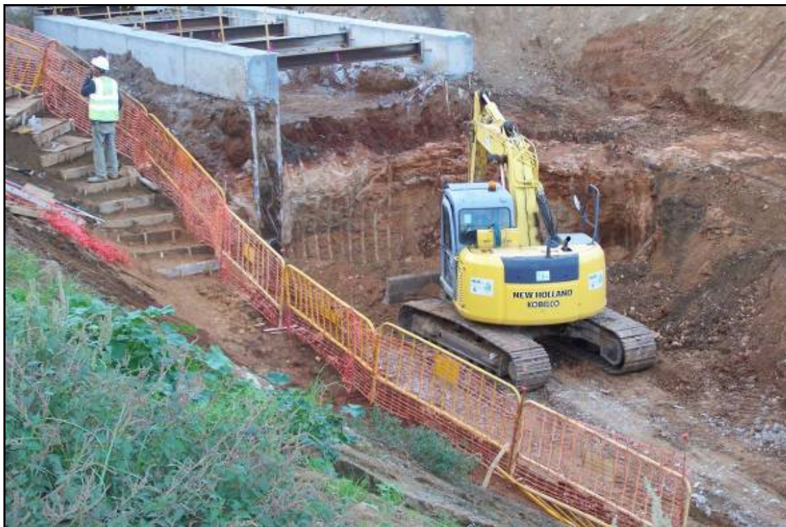
Fotografia 19: Inici de l'excavació entre pantalles en les Fases 1 i 2, pk. 0+000/0+100.
