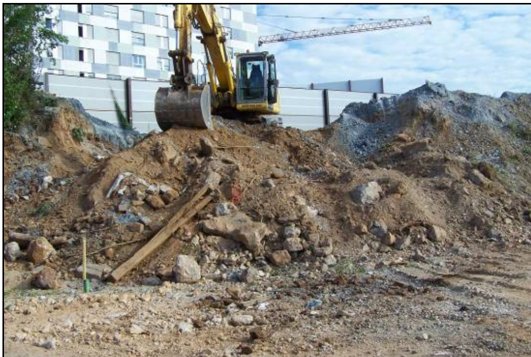
Fotografia 9: Retirada de material aportat per les obres de la L9 del Metro, Fase 6 (pk. 0+450/0+510).
