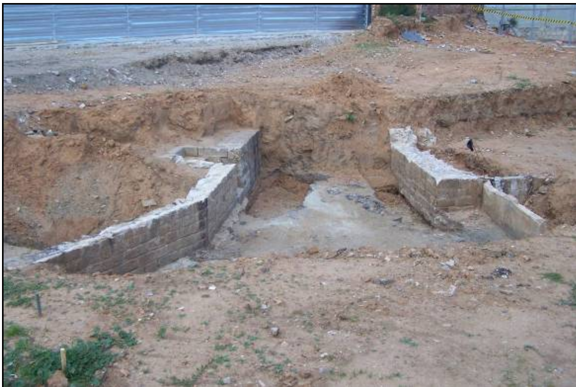
Fotografia 51: Vista general amb les UE 106, 111, 108, 113 i el nivell d'asfalt UE 103.
