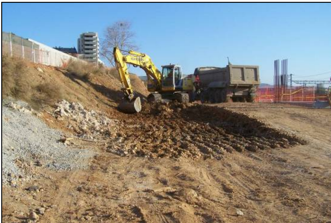
Fotografia 15: Inici d'excavació amb giratòria en la Fase 7, pk. 0+510/0+620.
