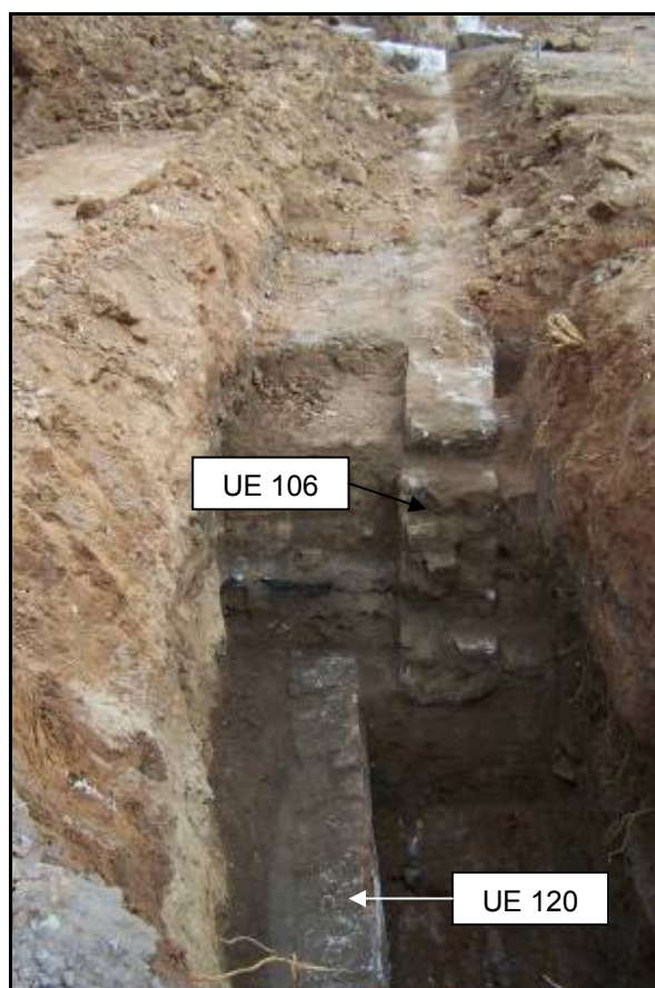
Fotografia 65: Vista de la claveguera UE 120 i el trencament del mur UE 106 en el seu extrem NE.
