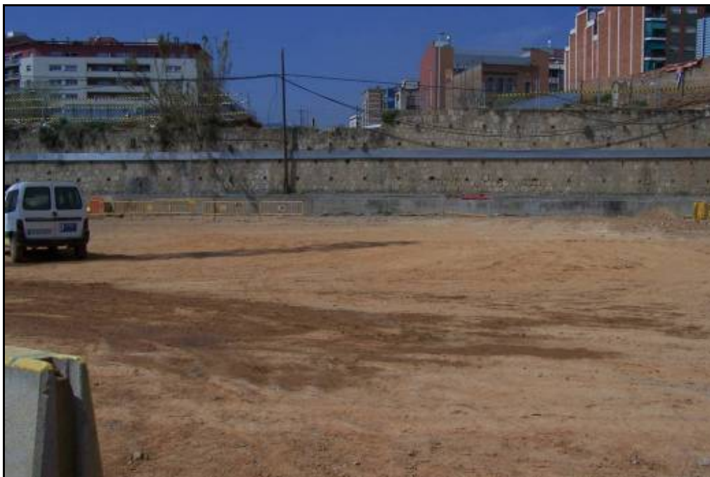
Fotografia 3: Fase 3A (pk. 0+100/0+150) del col·lector abans de l'inici de les obres. Al fons s'observa el mur de contenció que separa aquesta Fase de la Fase 2.
