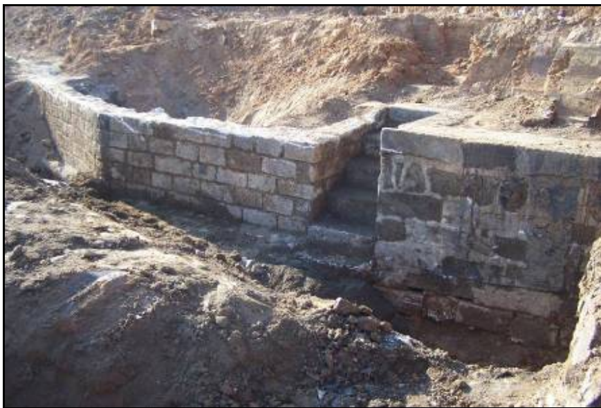
Fotografia 45: Vista general de murs 106, 108 i escala (UE 111) durant els treballs de neteja.
