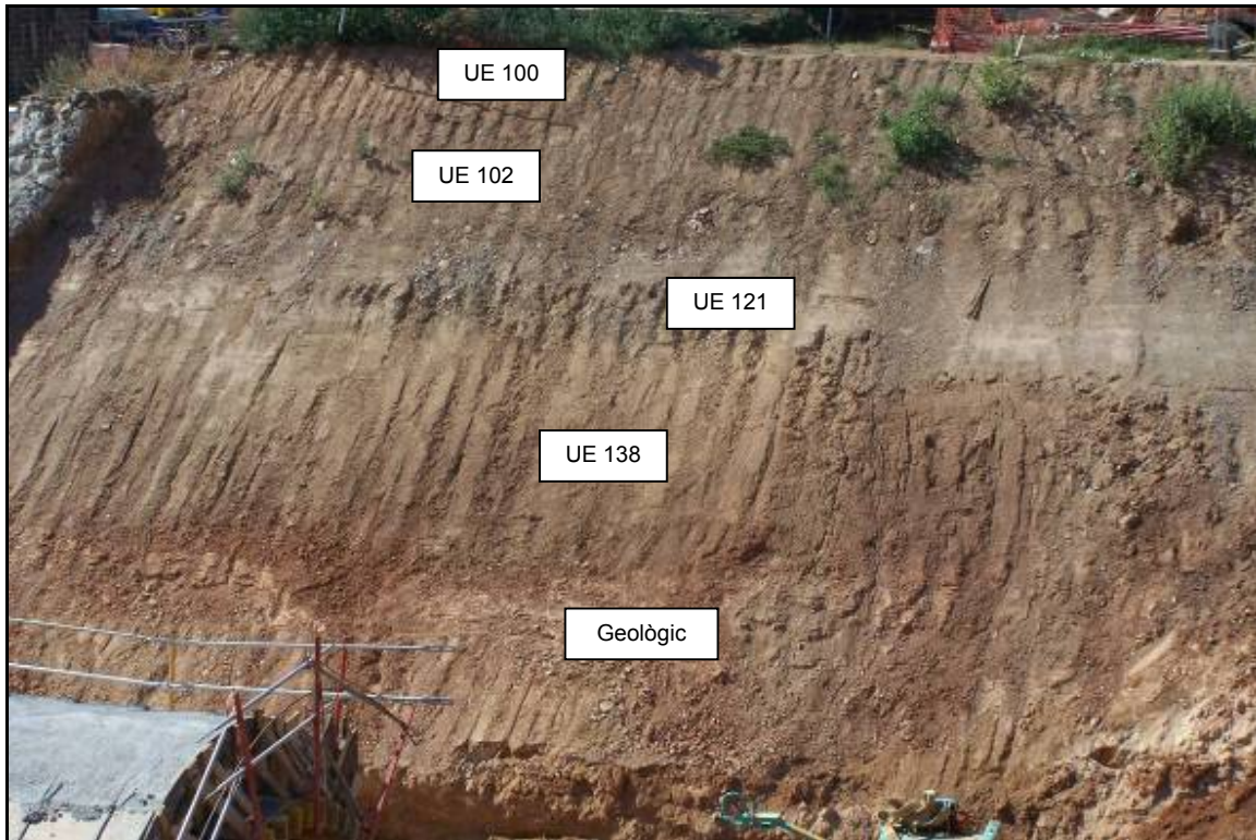
Fotografia 75: Estratigrafia general de la Fase 2, pk. 0+05/0+100, reflectida en el talús de la caixa del col·lector.
