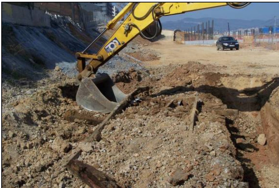
Fotografia 34: Aparició in situ de les vies en Fase 7 (pk. 0+570).
